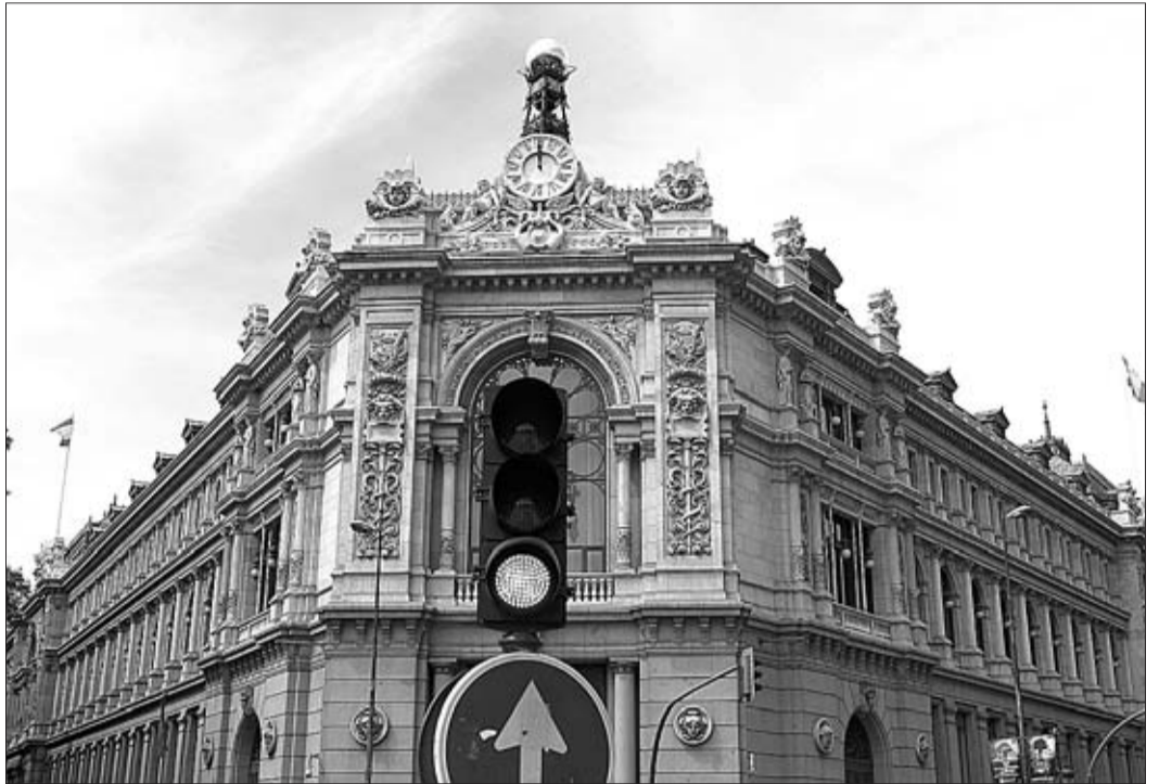
Fachada del Banco de España. PABLO MONGE
