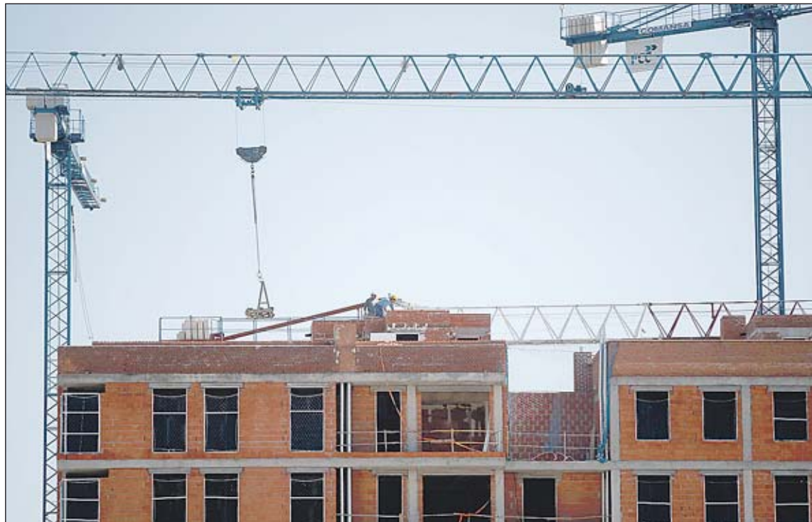
Edificio en construcción. REUTERS
