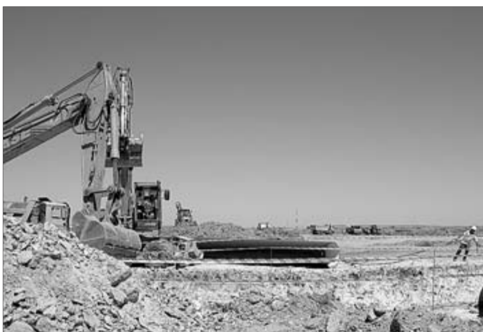
Operarios trabajan en las obras de una autovía. CINCO DÍAS
