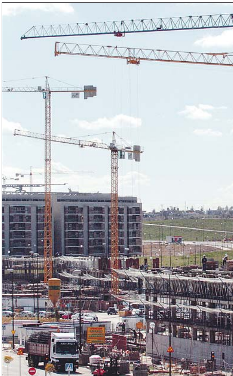
Edificios en construcción. EFE
