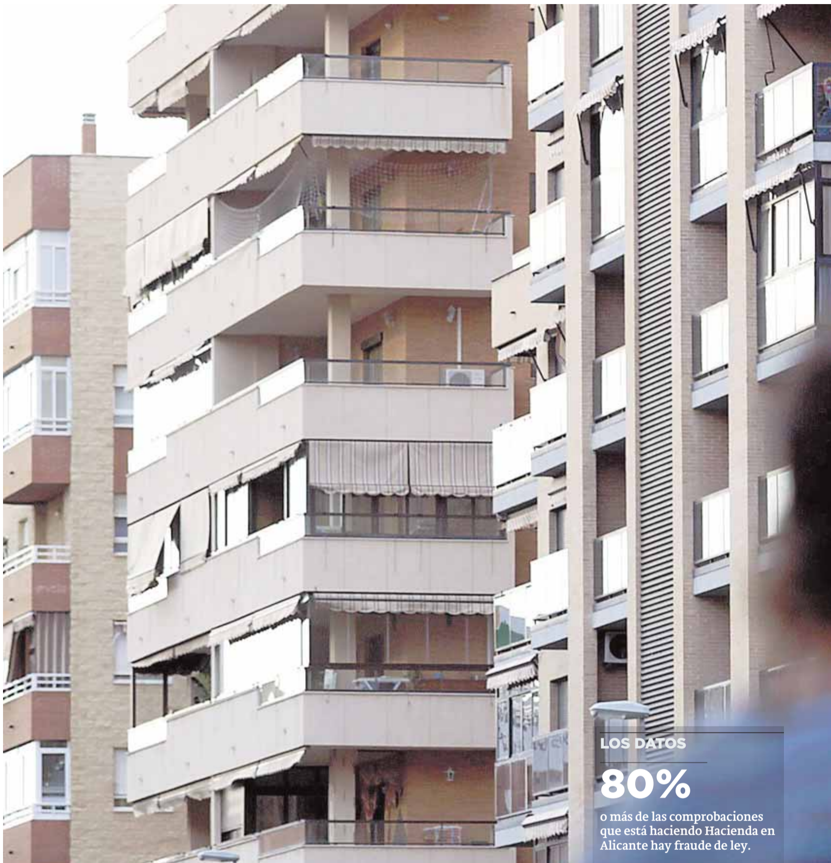
Bloque de viviendas de uso habitual en una zona de expansión de un barrio de Alicante. :: A. DOMÍNGUEZ
